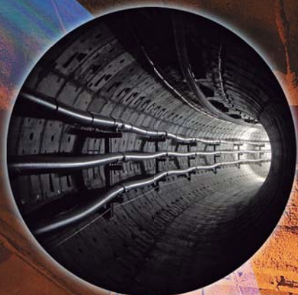
トンネル工事の方向設定
